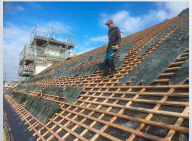
Anders Torkelsen sjekker at alt er i orden før skiferen legges på plass. 16000 skiferspiker skal slås i.
